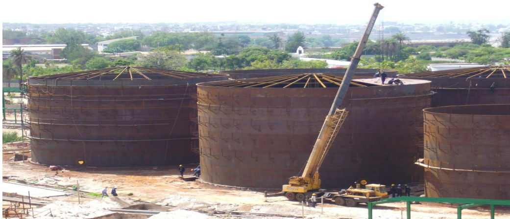
Photo n°4 : Construction des bacs ou réservoir à hydrocarbure.
